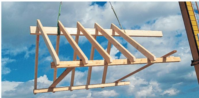
Fliegende Dachstühle: Zur Endmontage muss der Dachstuhl per Kran in die Höhe transportiert werden. Foto: Holzbau Fürst
